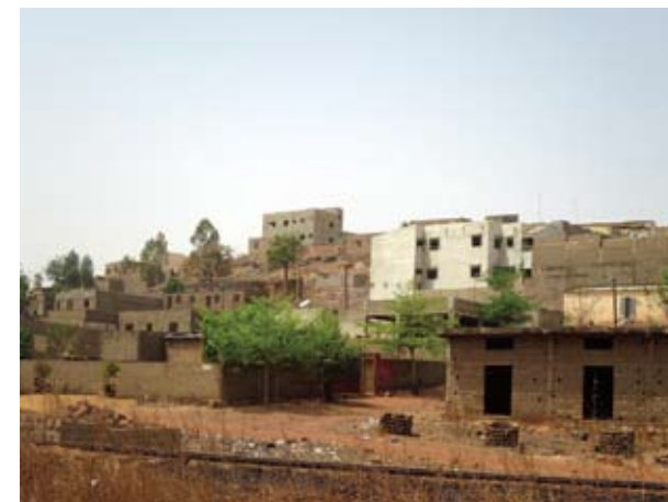
建設中の住宅
