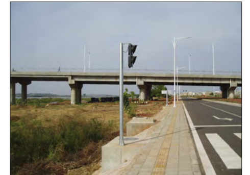
新しい橋と舗装された道
